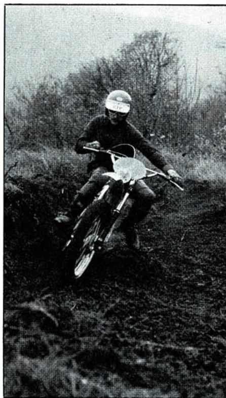
Altri momenti della nostra prova. La Scarab C risponde bene nei salti e nel controsterzo. Nelle discese bisogna spostarsi il più possibile all'indietro per evitare impuntamenti dell'avantreno causati dall'interasse contenuto.
